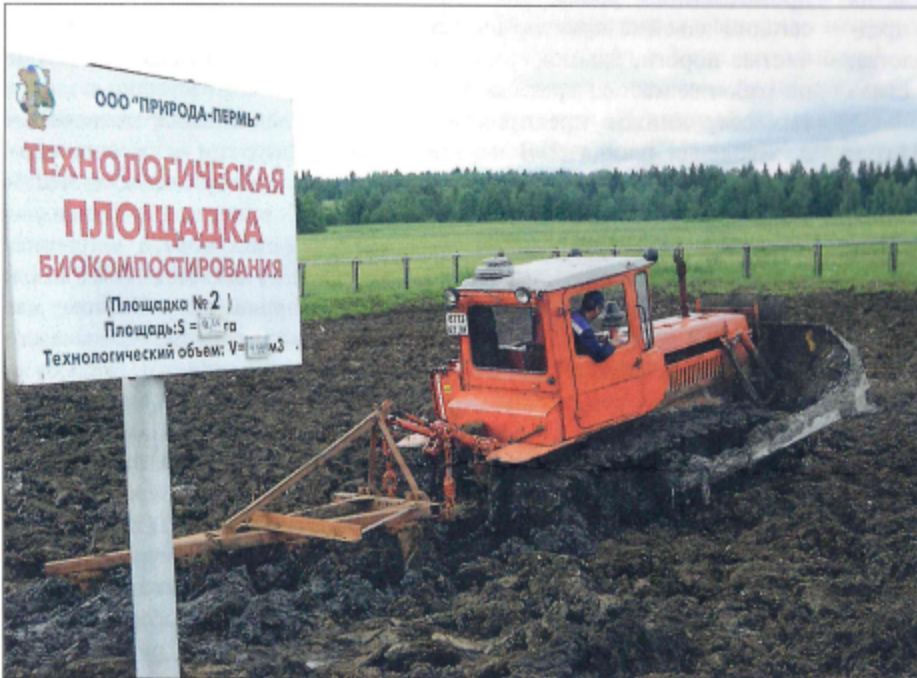
Идет процесс биоремедиации. Для увеличения аэрации нефтезагрязненного грунта его обрабатывают с помощью сельхозорудий
